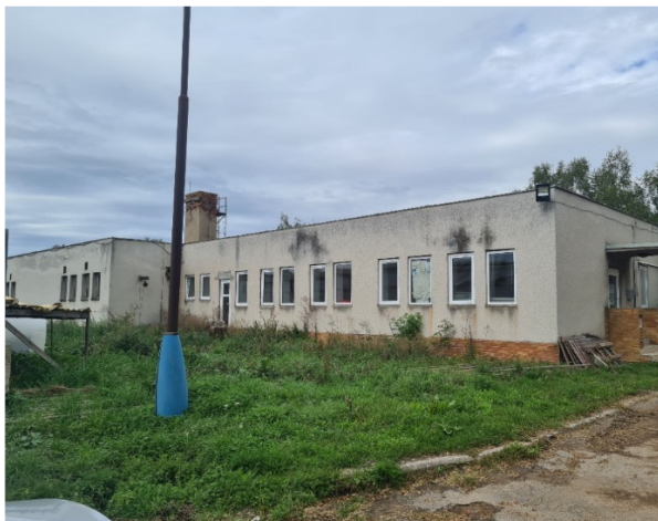
Administrativní budova VKK
